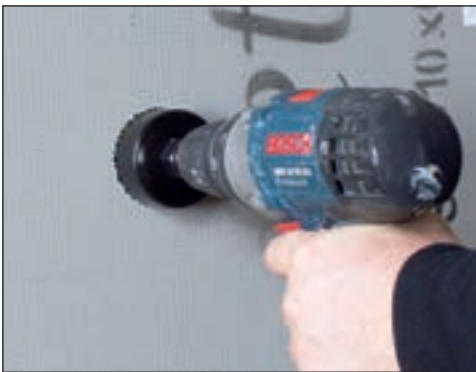
Det er enkelt å ta hull med hullbor.
