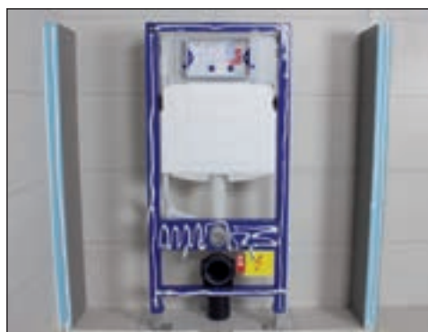
Påfør monteringslim på ramme og sidevegger.
