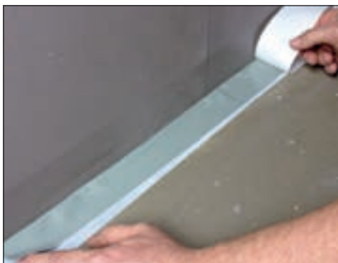
Båndets dekkpapir er todelt - enkel montering.
