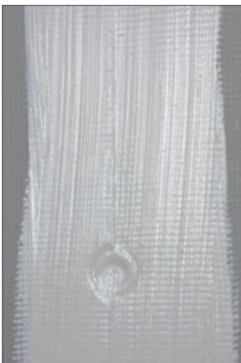
Påfør nye strøk med membran.
