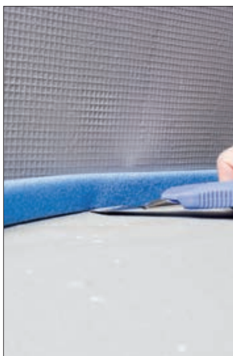
Overskytende ekspansjonsbånd fjernes.
