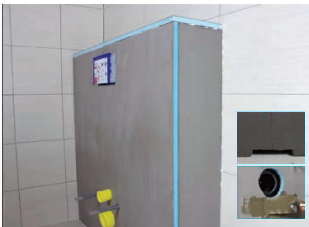
Lag dremsåpning og forsterkning. Toalettplaten er klar for flislegging når limet har tørket.
