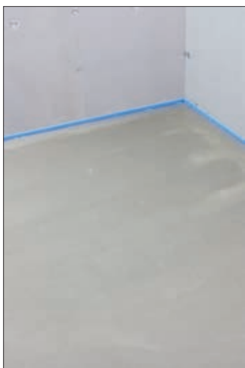
Ferdig avrettet gulv.
