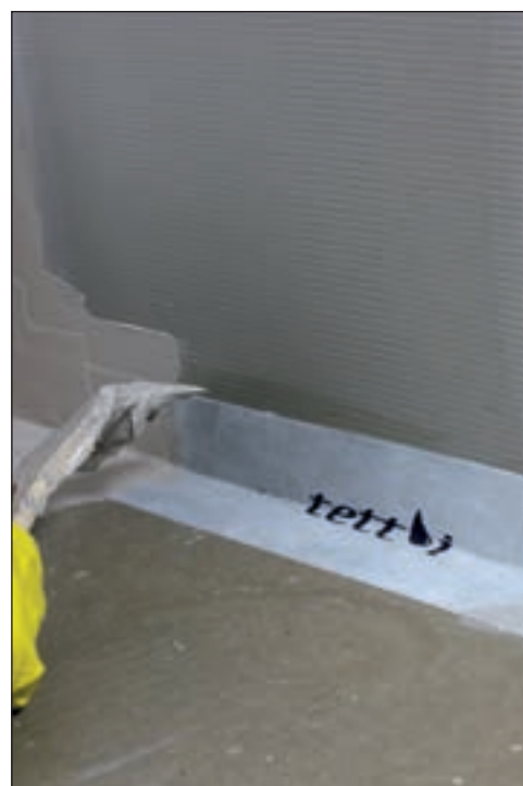
Selvklebende bånd dekkes med membran.
