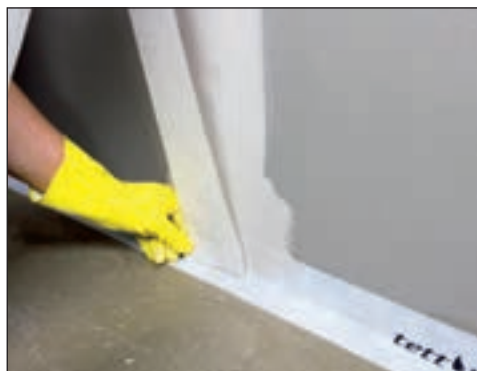
Legg fiberremsen i våt membran.
