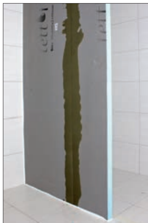
Dusjevegg klar for flislegging.
