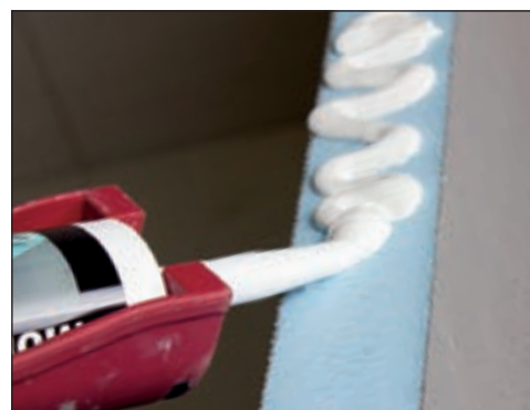
Påfør tilstrekkelig med Tetti monteringslim.
