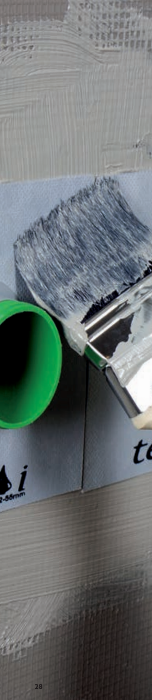
Bruk maskeringstape for å unngå søl på røret.
