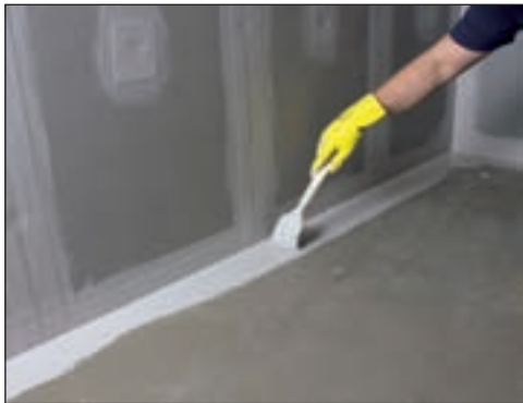
Påfør membran langs veggene med pensel.
