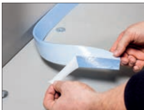
Benytt ekspansjonsbånd langs alle vegger.
