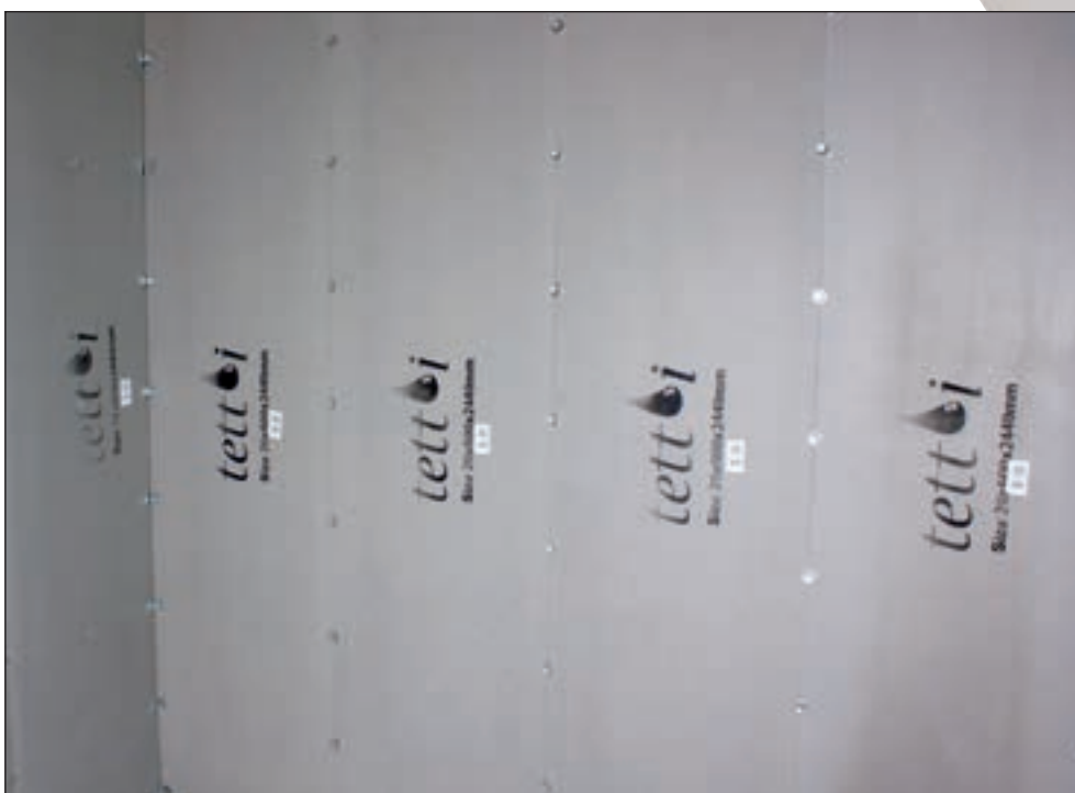
Fest skrue med monteringskive i alle skjøter, maks avstand 30cm.
