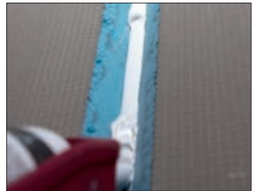
Påfør lim i rørkassens v-spor.
