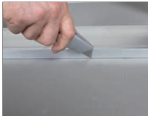
Platene kuttet enkelt med tapetkniv.
