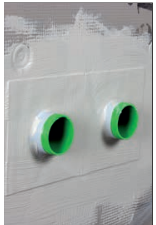
Påfør nye strøk med membran.
