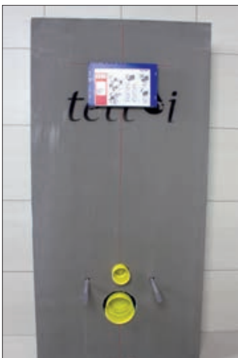
Lag dreksåpning og forsterkning. Toalettkassen er klar for flislegging når limet har tørket.
