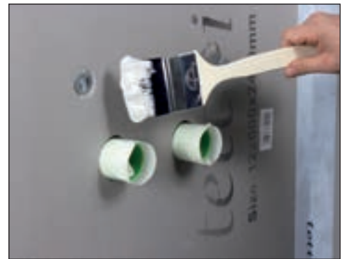
Påfør membran i et tilstrekkelig stort område.
