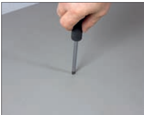
Lag hull til senter av limpunktene.
