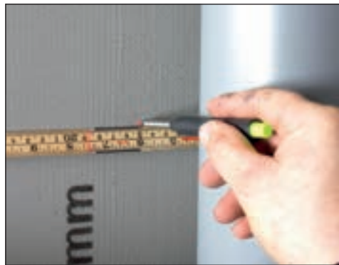
Ta mål og tilpass rørkassen i høyde.
