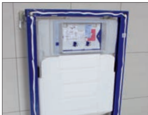
Påfør monteringslim på ramme, vegg og gulv.
