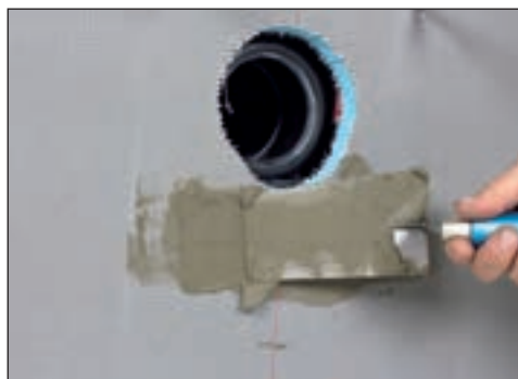
Lag dreksåpning og forsterkning. Toalettkassen er klar for flislegging når limet har tørket.
