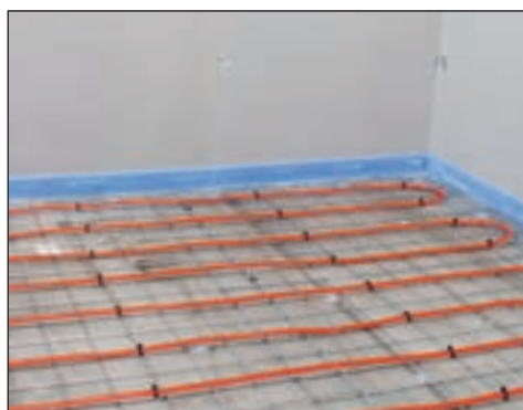
Benytt armeringsnett når dette er påkrevd.
