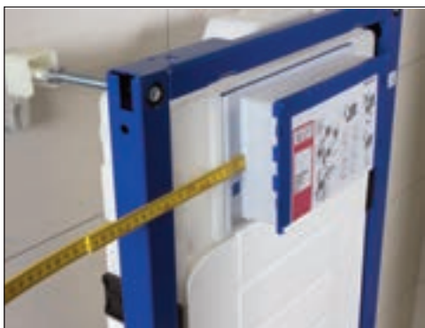
Ta mål og tilpass kassen.
