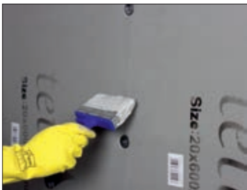
Påfør membran på hver side av plateskjøt.
