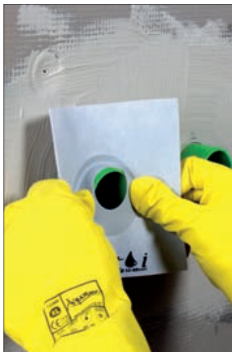
Tre mansjetteen forsiktig på røret.
