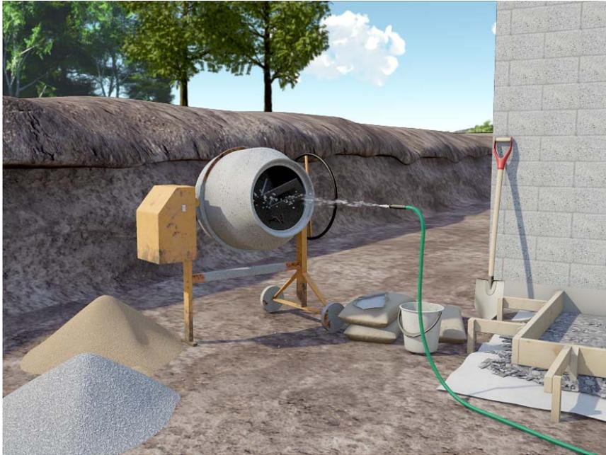
**8. Bruk ferdigblandet ”grovbetong” når du trenger en mindre mengde med betong.**
