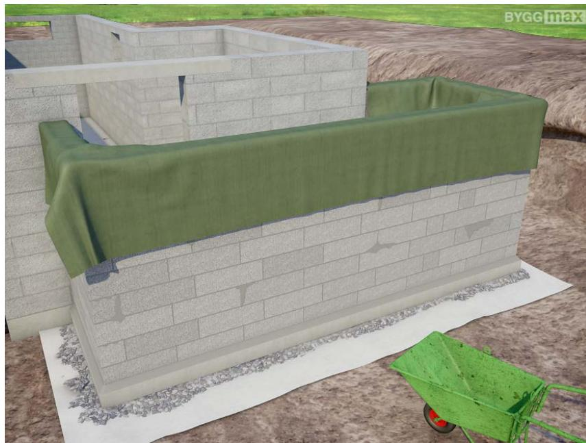
**23.** Ved varmt vær vanner du overflaten etter ett døgn, ellers kan flaten herde for fort og sprekke.
